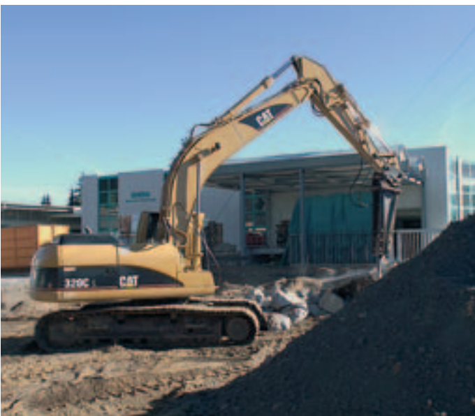
Der Bagger rollt an! Die neue Lagerhalle wird Stellplätze für 750 Paletten auf 630 m 2 bieten.
