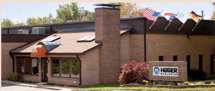
Der neue Hauptsitz von Hager Worldwide in Hickory, North Carolina.
