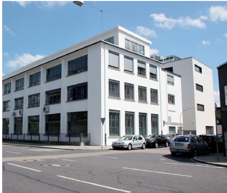
Über 13 Millionen Euro wurden in rund zweieinhalb Jahren verbaut. Das Ergebnis kann sich sehen lassen: das entsprechend neuester Standards modernisierte FORESTADENT Stammhaus (vorn) sowie die dahinter befindliche, neu errichtete Produktionsstätte.
