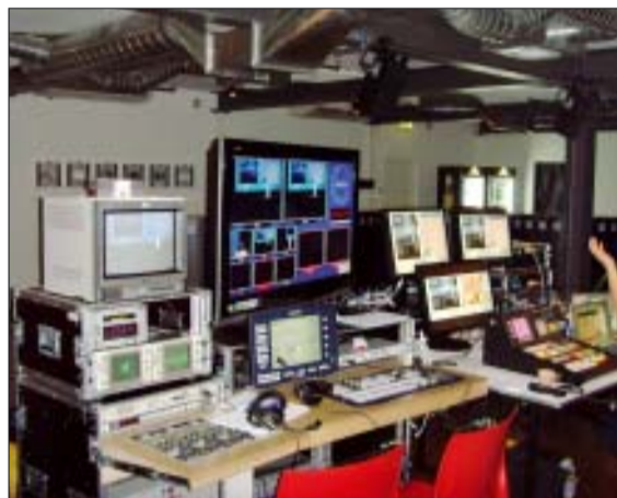
50 Techniker waren im Einsatz, um das Mega-Projekt zu stemmen.
